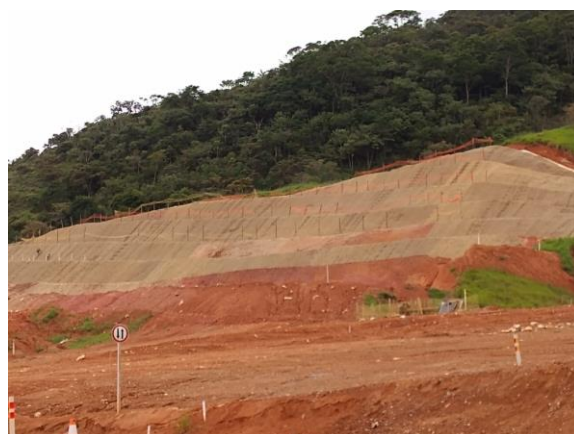
Taludes na Área 1. Data: 05/02/2020 . Fonte: Assessoria Técnica Cáritas.
