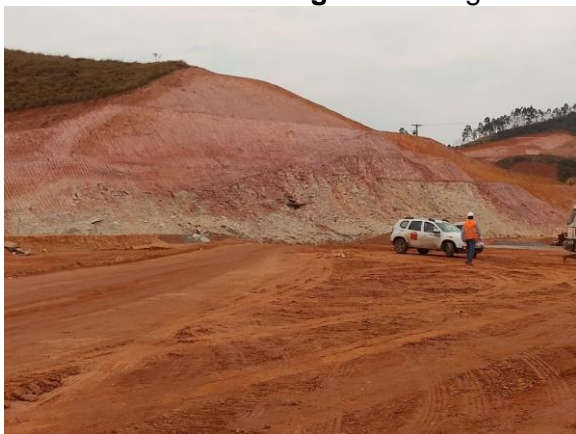
Taludes aos fundos de lotes. Data: 05/02/2020 . Fonte: Cáritas.
