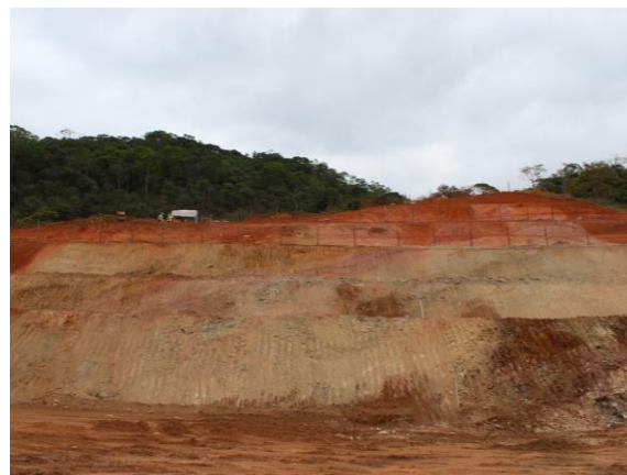
Taludes na Área 1. Data: 23/10/2019 . Fonte: Assessoria Técnica Cáritas.
