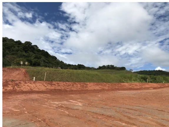
Taludes aos fundos de lotes com início de proteção usando biomanta. Data: 22/02/2021 . Fonte: Cáritas.
