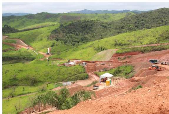
Vista geral da área do reassentamento coletivo. Data: 15/01/2020 . Fonte: Assessoria Técnica Cáritas.
