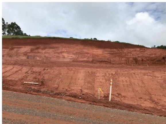
Taludes aos fundos de lotes. Data: 22/02/2021 . Fonte: Cáritas.
