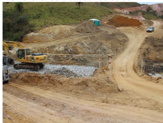
Serviços de terraplanagem. Data: 14/08/2019 . Fonte: Assessoria Técnica Cáritas.
