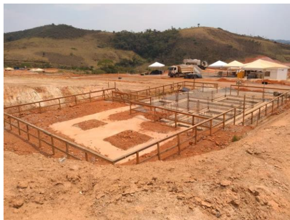
Fundação da casa. Data: 08/10/2020 . Fonte: Assessoria Técnica Cáritas.
