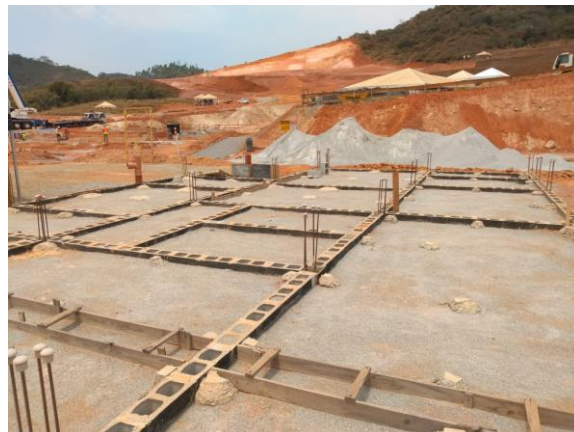
Fundações de uma casa. Data: 08/10/2020 . Fonte: Assessoria Técnica Cáritas.
