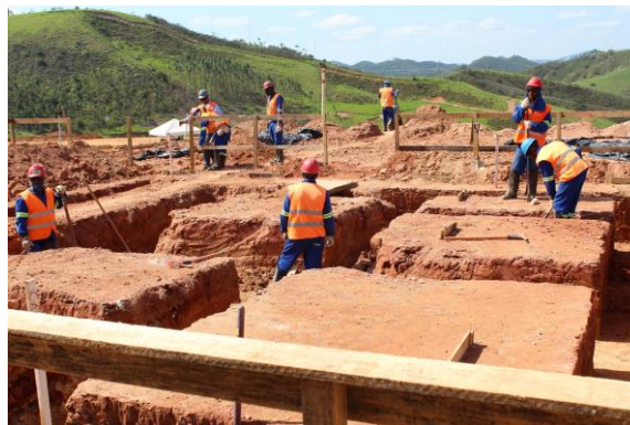
Escavação para fundação de edificação. Data: 27/11/2019 . Fonte: Assessoria Técnica Cáritas.
