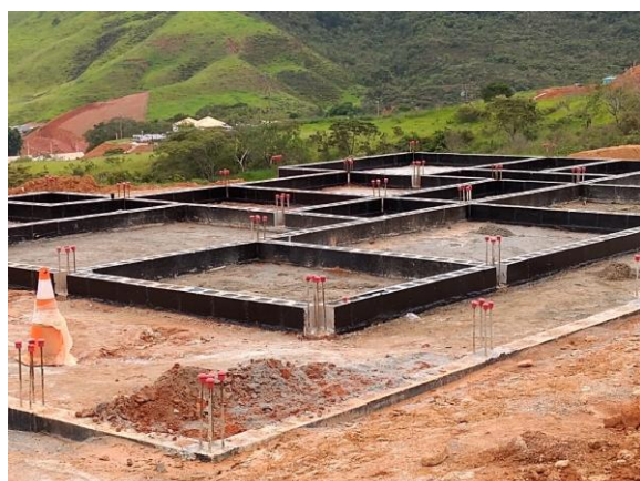
Execução da fundação de uma casa. Data: 05/02/2020 . Fonte: Assessoria Técnica Cáritas.
