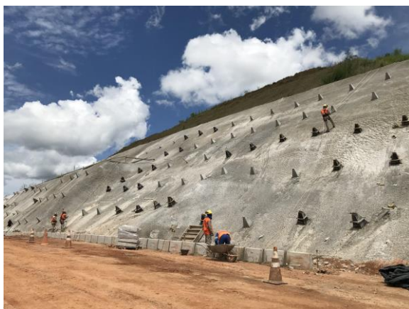
Serviços de contenção de taludes do acesso principal ("trincheira") ainda em execução. Data: 25/02/2021 . Fonte: Assessoria Técnica Cáritas.
