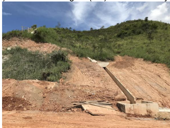
Execução da rede de drenagem. Data: 25/02/2021 . Fonte: Assessoria Técnica Cáritas
