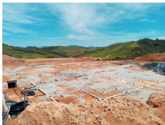
Fundações da escola. Data: 15/12/2020 . Fonte: Assessoria Técnica Cáritas.
