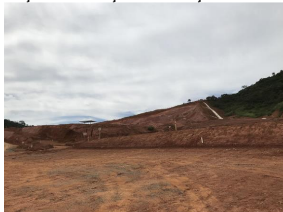
Trecho próximo à Praça Santo Antônio (Área 1) sem nenhum trabalhador. Data: 25/02/2021 . Fonte: Assessoria Técnica Cáritas.
