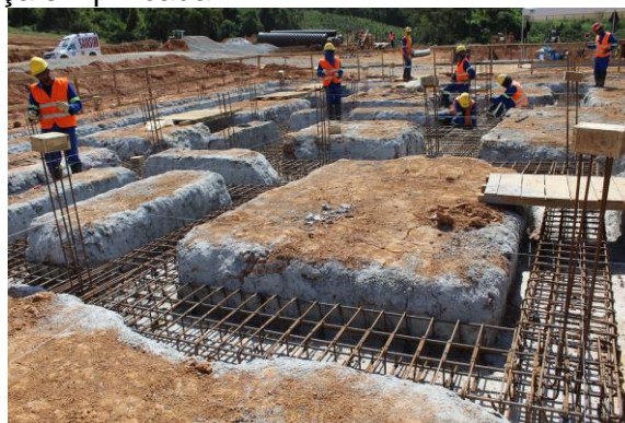
Fundação de casa. Data: 18/12/2019 . Fonte: Assessoria Técnica Cáritas.
