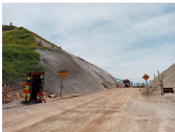
Acesso principal. Data: 15/12/2020 . Fonte: Assessoria Técnica Cáritas.
