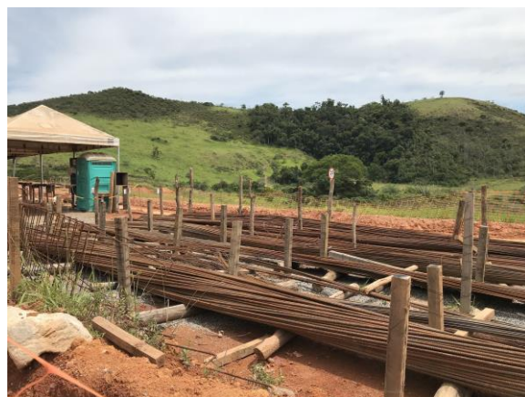
Ferragens que seriam usadas nas estruturas de concreto armado das casas (obras paralisadas) danificadas pela exposição ao sol e chuva. Data: 25/02/2021 . Fonte: Assessoria Técnica Cáritas.
