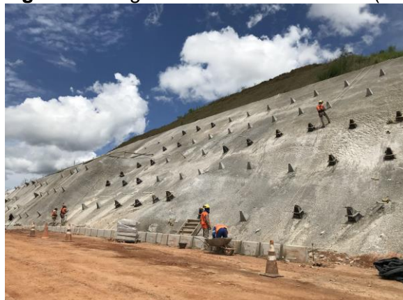
Execução da contenção do talude do acesso principal (método de atirantado). Data: 25/02/2021 . Fonte: Assessoria Técnica Cáritas.
