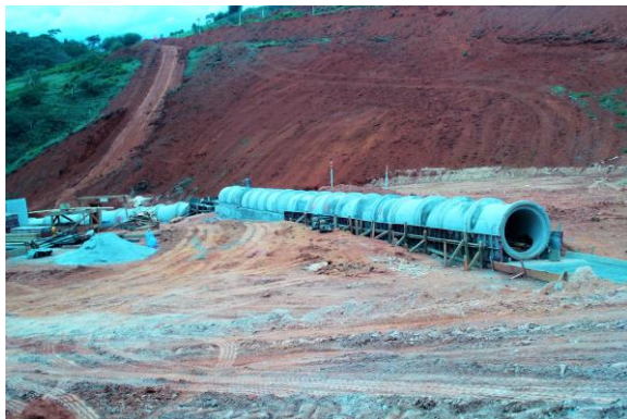
Infraestrutura urbana. Data: 14/11/2019 . Fonte: Assessoria Técnica Cáritas.
