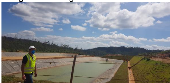
Estação de Tratamento de Esgoto. Data: 30/01/2021 . Fonte: Assessoria Técnica Cáritas.
