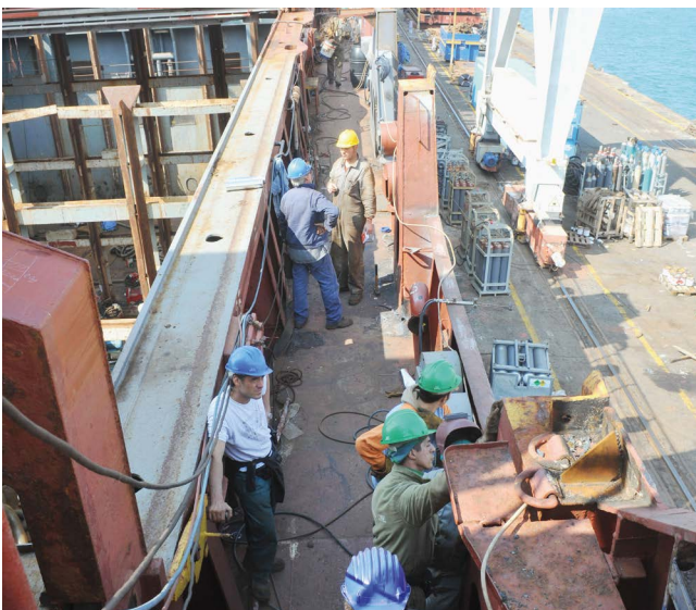
Renovierungsarbeiten auf dem italienischen Schiff "Ameilia Star".
