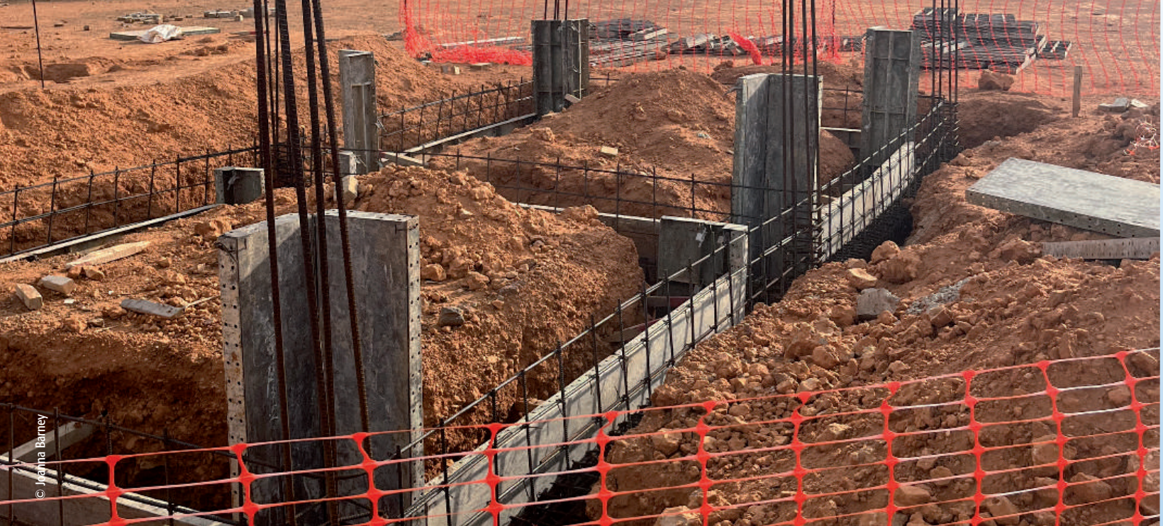
Foto 8. Cimientos construidos para casas Wayuu.
