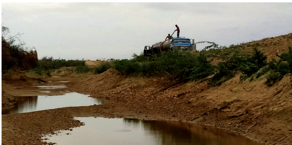
Foto de la captación de agua de escorrentía efectuada por la empresa Operaciones y Montajes de La Guajira Fuente: foto dada por comunidad
