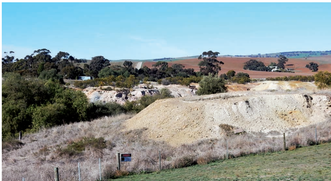
Figura 10. Depósito de relaves filtrados en Kapunda, Australia del Sur.
