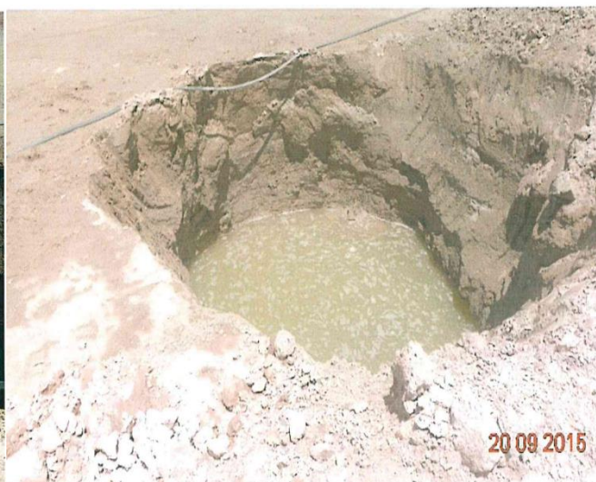
Fotografía N° 09. Nivel de agua en la calicata registrado durante la primera visita realizada el día 20 de septiembre
