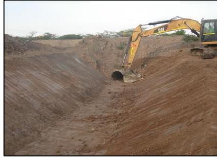
**Fase de adecuación del canal para la instalación del manto**
